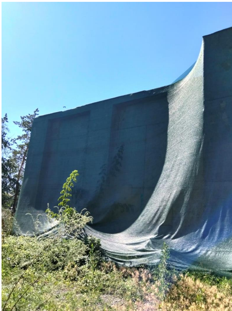
Фото 23. Повторный вид повреждённой сетчатой декоративной оболочки, подтверждающий её провисание и нештатное положение относительно основания.
