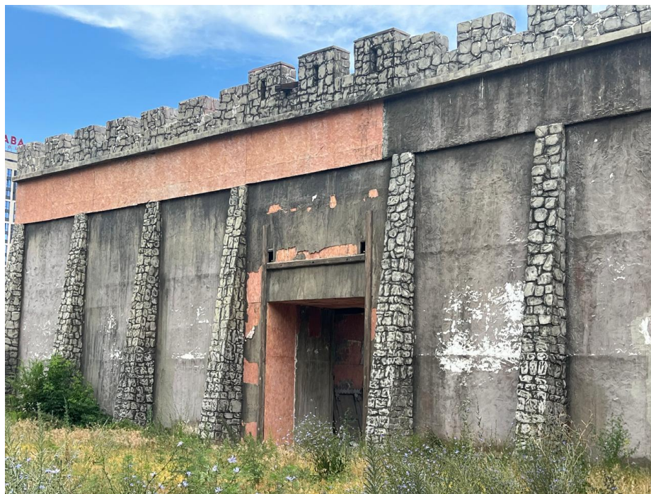
Фото 16. Наружная декоративная стена с выраженным атмосферным старением и локальной утратой защитно-отделочного покрытия.
