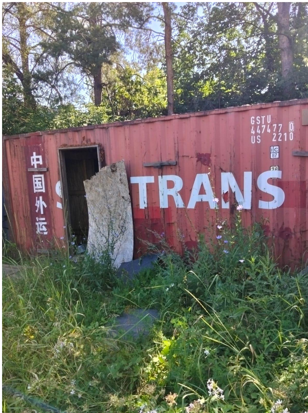
Фото 2. Крупный вырез в боковой стенке контейнера, выполненный при переоборудовании под декорацию. Контур проема и прилегающие участки имеют следы атмосферного воздействия.
